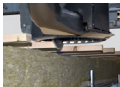
Façonnage des lattes de toit
